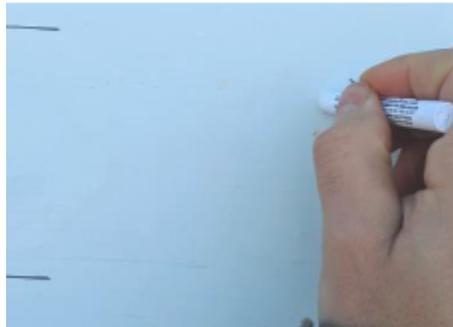
6. Utiliser la plaque de montage en surface comme modèle pour marquer l'emplacement d'installation du ST 2100.
